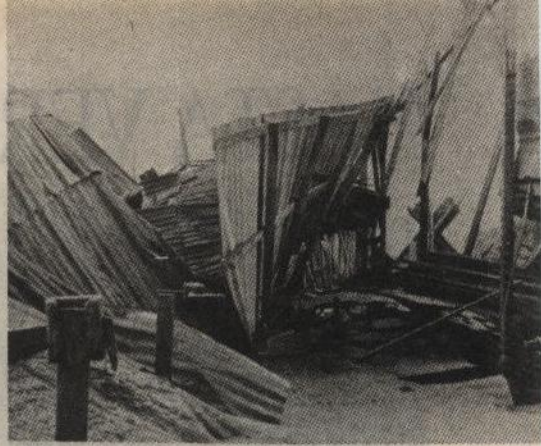
Muchas casas de la región de Arenal quedaron completamente destruidas por el violento terremoto de 1973.
