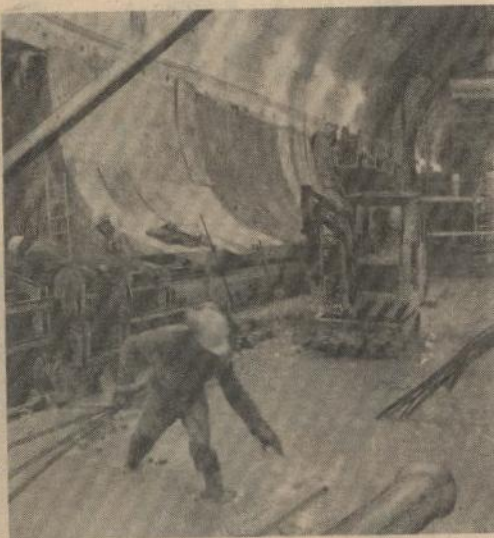
Cientos de trabajadores construyen el túnel bajo el fondo del mar.
